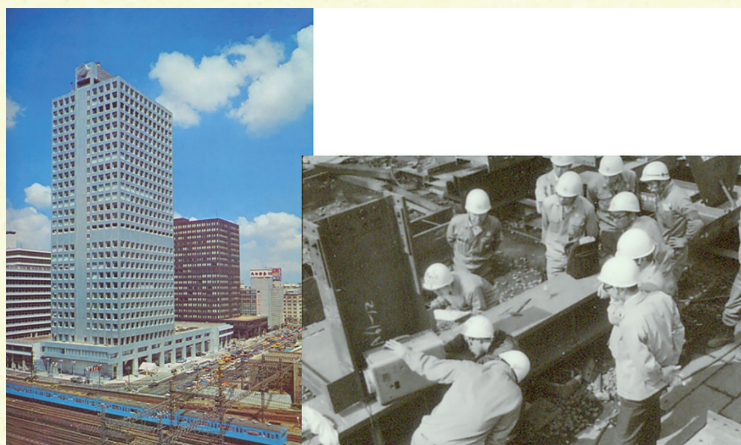
図1 溶接部の超音波探傷検査（UT）写真左：朝日東海ビルディング（現・朝日生命大手町ビル・全面的にUTを採用した初めての建物）写真右：UTの実施状況（現在）
